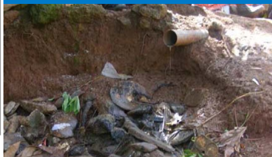
| Figure 4 | Déversement d'eaux usées dans la rivière à Koungou
