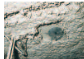
Flocage de plafond
