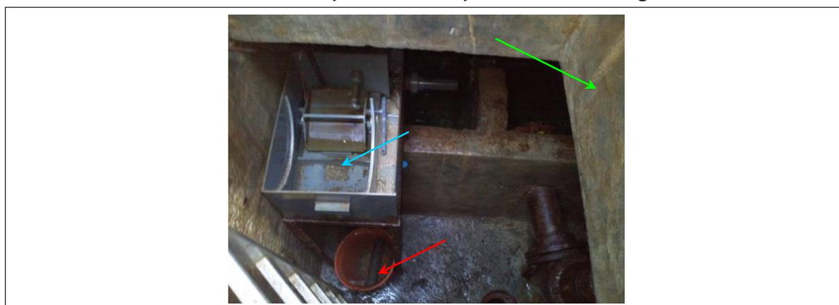
Note : prélèvement d'eau dans le seau du répartiteur resté plein suite à la vidange (flèche rouge). La flèche verte indique le niveau de l'eau au moment de l'inondation. La flèche bleue indique le système de chloration "flip flop".
