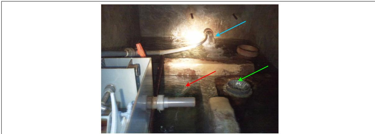
Note : prélèvement d'eau dans le bac du répartiteur juste après la vidange (flèche rouge). La flèche verte indique la canalisation d'évacuation bouchée lors de l'inondation. La flèche bleue indique l'arrivée d'eau des trois captages.
