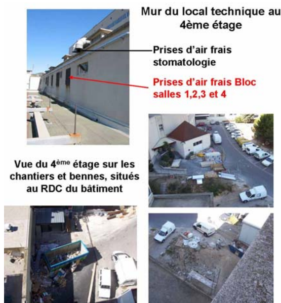
Figure 3 – Sources possibles d'émanation d'air « vicié » au niveau du bloc opératoire central de l'hôpital Nord, Marseille, août 2005
